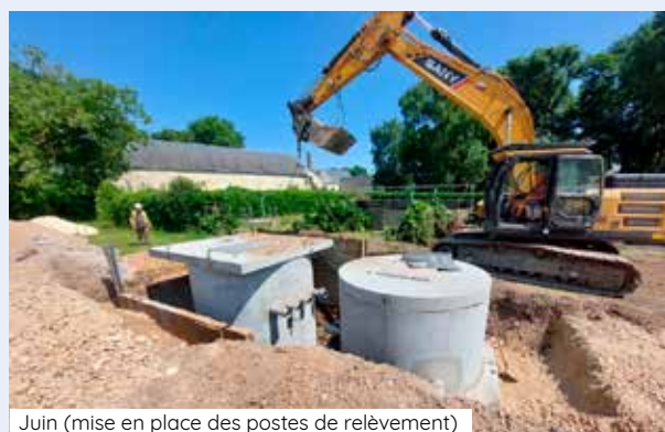
Juin (mise en place des postes de relèvement)
