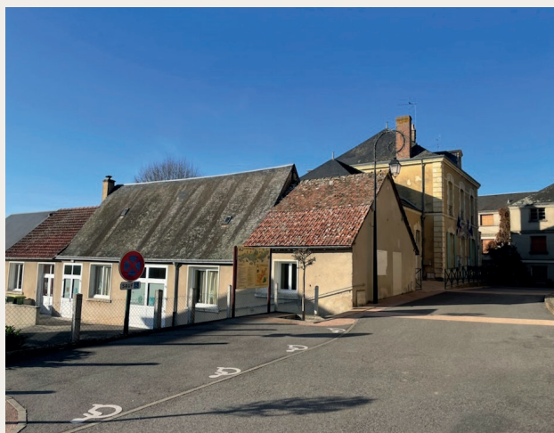
Chaufferie Biomasse à La Chapelle Gaugain
