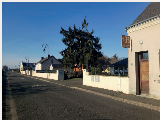
Chaufferie Biomasse à Ruillé-sur-Loir
